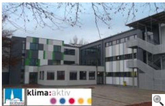
Hauptschule/NMS Weißkirchen – Sanierungsprojekt des TBH
