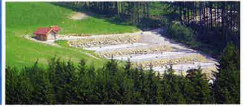
Pflanzenkläranlage in Kürnberg.
